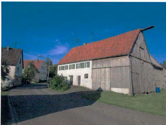
Leerstehendes landwirtschaftliches Anwesen Lindenstraße 11 im Nordwesten des Baugebietes (Bauplatz 2)
