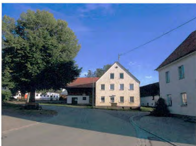
Blick von Norden auf das Gebäude Lindenstraße 5 im Osten des Baugebietes
